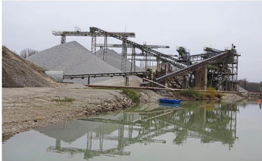
Kieswerk Helmigen: Der Kiesabbau, ermöglicht Rheinau bisher ein sorgenfreies Leben. Ob man sich das weiterhin auf Kosten des Naturschutzes leisten will, muss der Gemeinderat nach der Ausarbeitung eines Strategieprozesses entscheiden. Foto: Karen Christeleit
